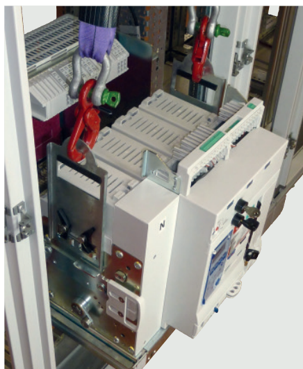
Instalación de un DMX 3 extraíble en su base
