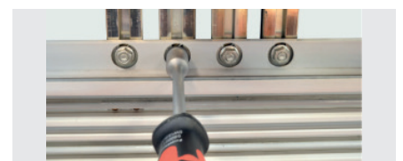
Los repartidores de fila están preequipados con pernos de cabeza de martillo. Apriételes para conectar el repartidor al sistema de barra.
