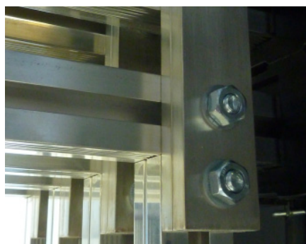
Conexión entre un sistema de barra de aluminio y un sistema de barra principal doble creada utilizando barras de aluminio
