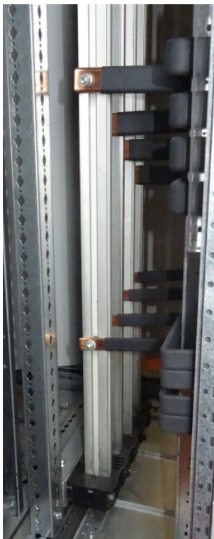
Instalación de sistema de barra en celda lateral.
