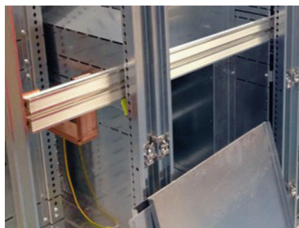
Borna principal formado por una barra de cobre o aluminio
