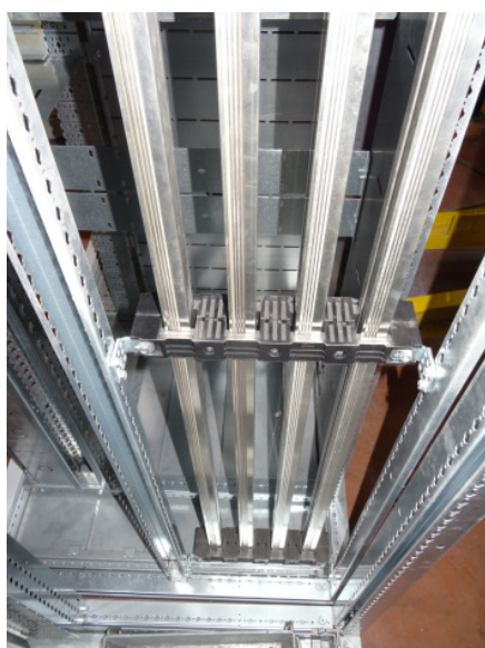
Coloque el sistema de barra y apriete los soportes para garantizar que las barras se mantengan en su lugar. (Par de apriete: consulte la página 27)
