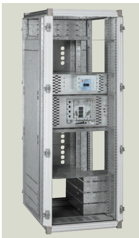
Ejemplo: Tablero Forma 4b en proceso de montaje
