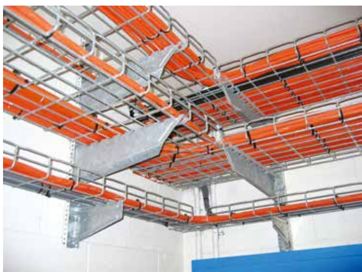
Ejemplo de espacio utilizado por un sistema de bandejas de cables
