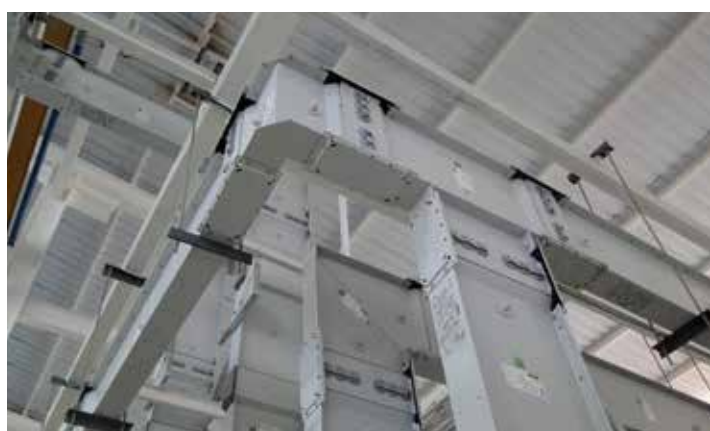
Ejemplo de sistema de canales de distribución de Legrand
